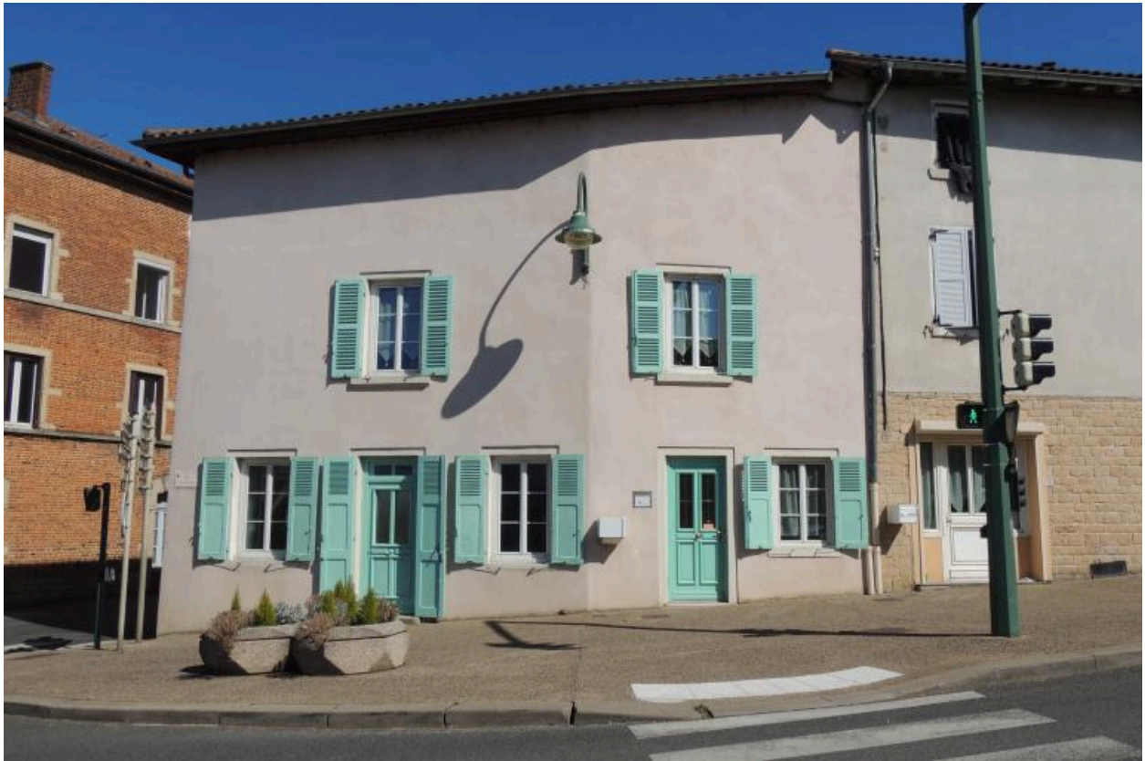
Façade sur la rue Gombette.
