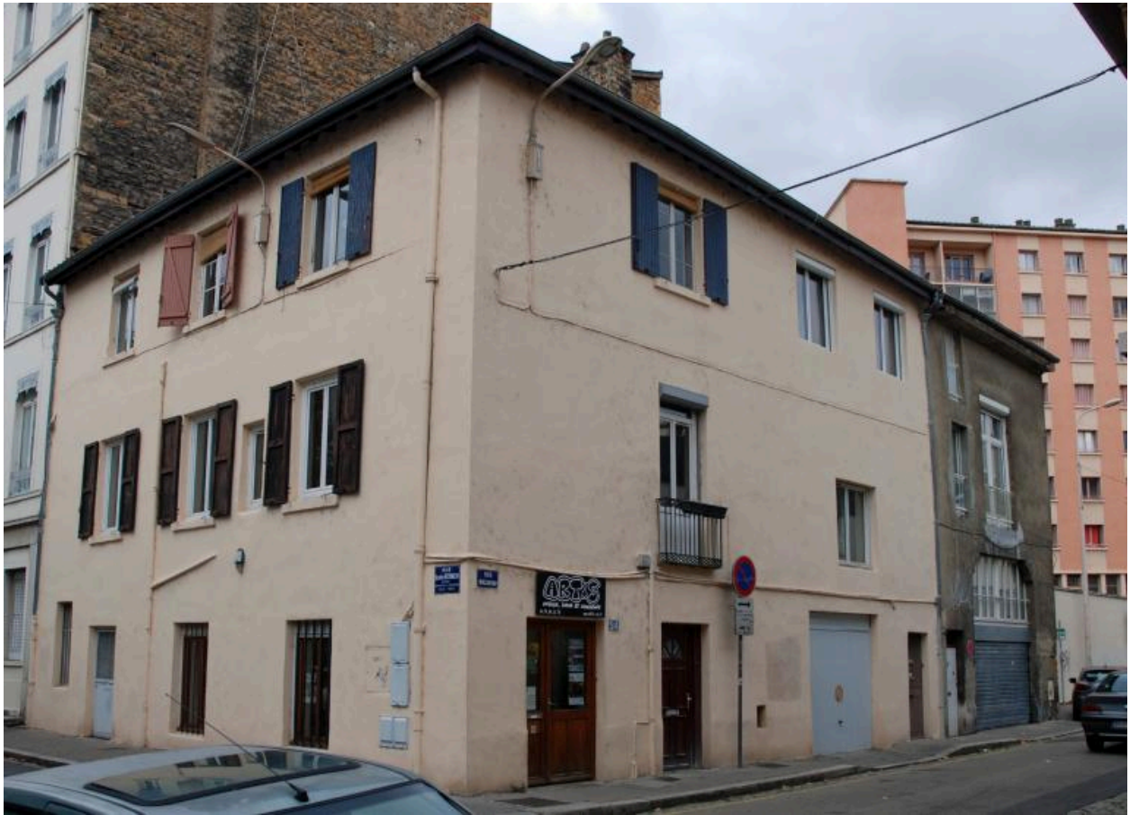
Vue d'ensemble depuis le sud-est, état actuel
