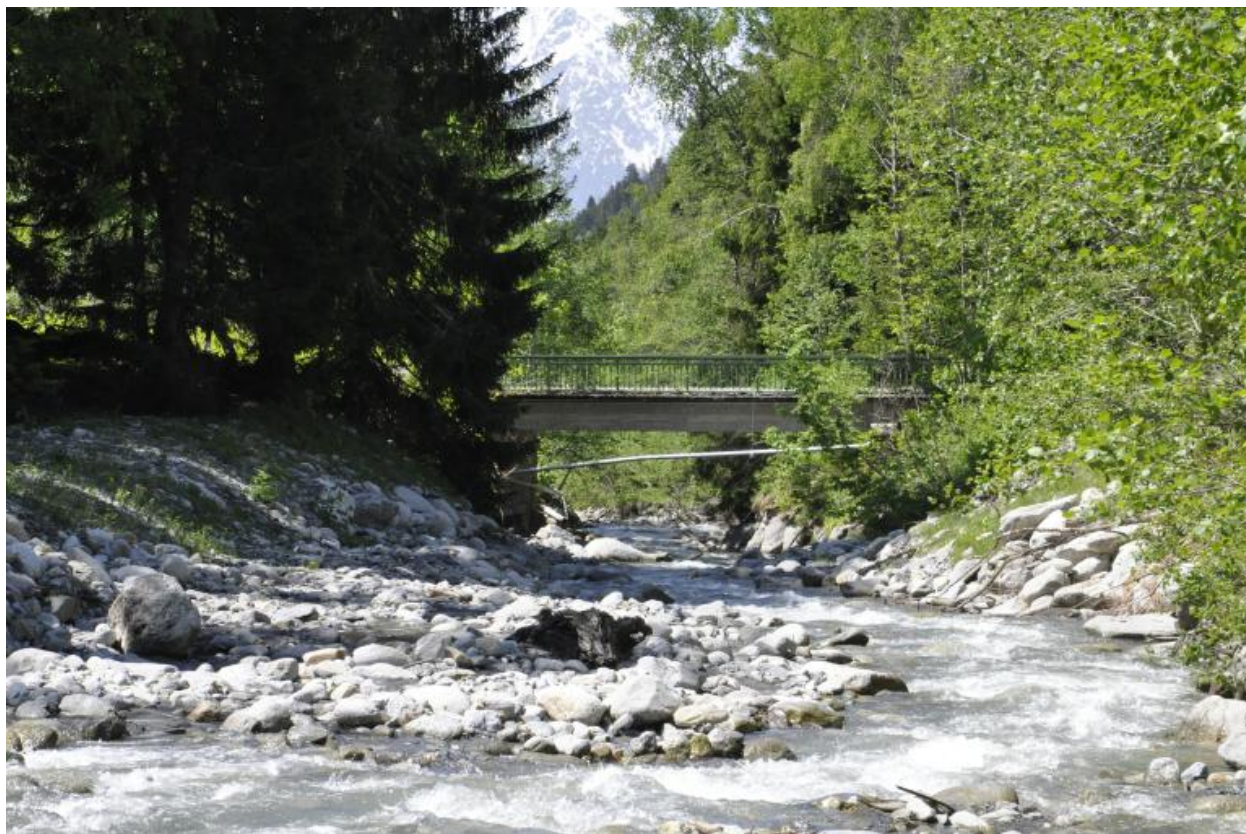
Vue de la face amont du pont
