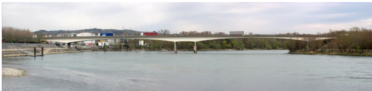
Vue panoramique, côté aval
