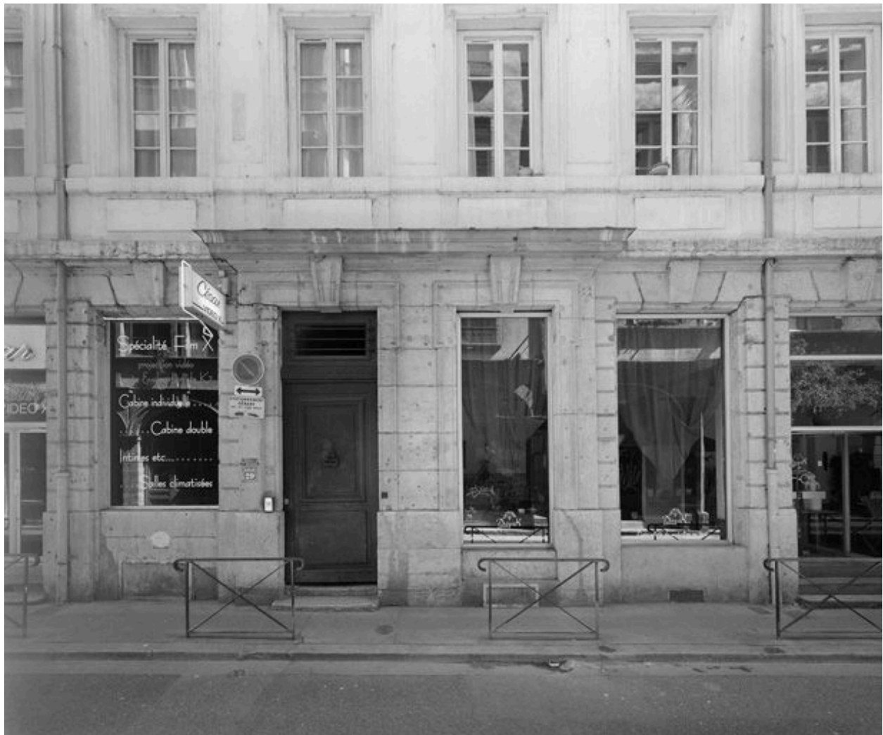
Façade, rez-de-chaussée, détail des travées centrales
