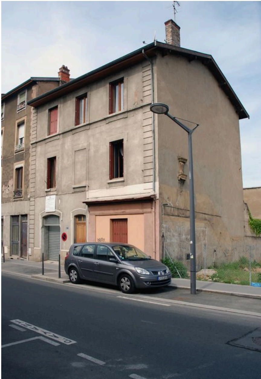
Elévation antérieure, vue depuis le Nord-Ouest
