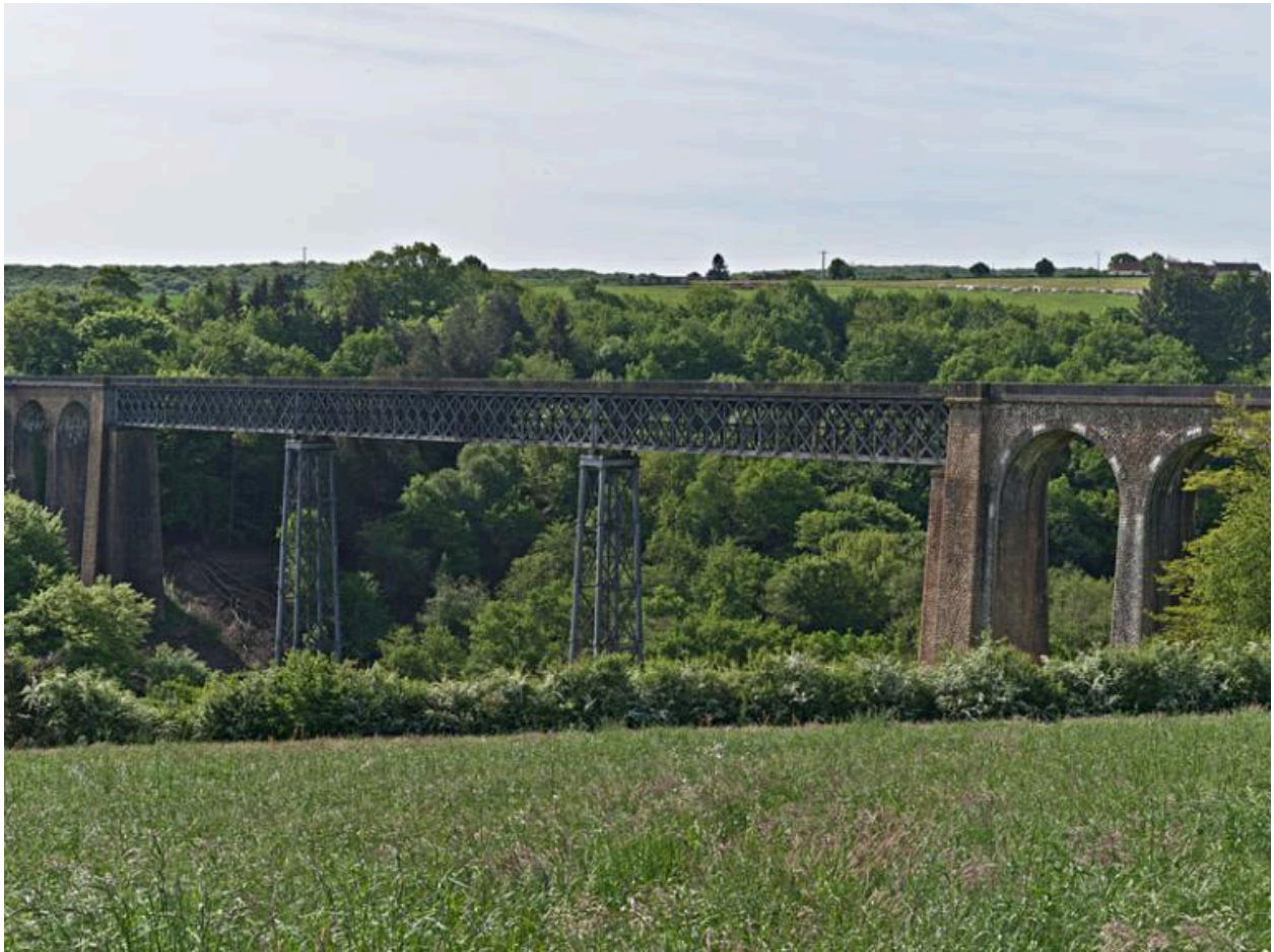
Vue de la partie centrale, à structure métallique, du viaduc.
