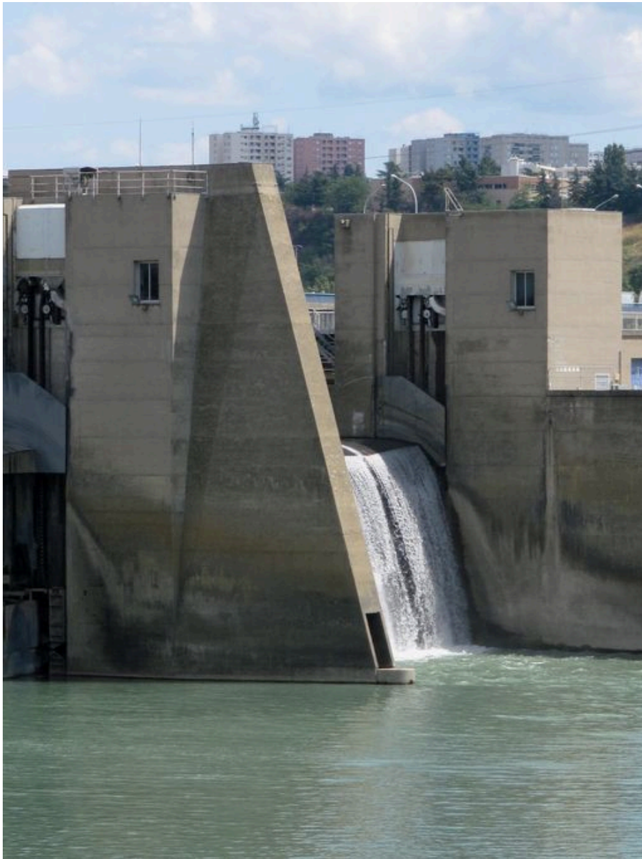
Vue d'une passe du barrage, face aval (depuis la rive droite)
