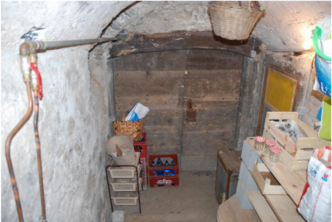
Sous-sol, porte d'accès à la cave voûtée depuis la salle à manger du rez-de-chaussée (Cf. Plan RDC 8b).
