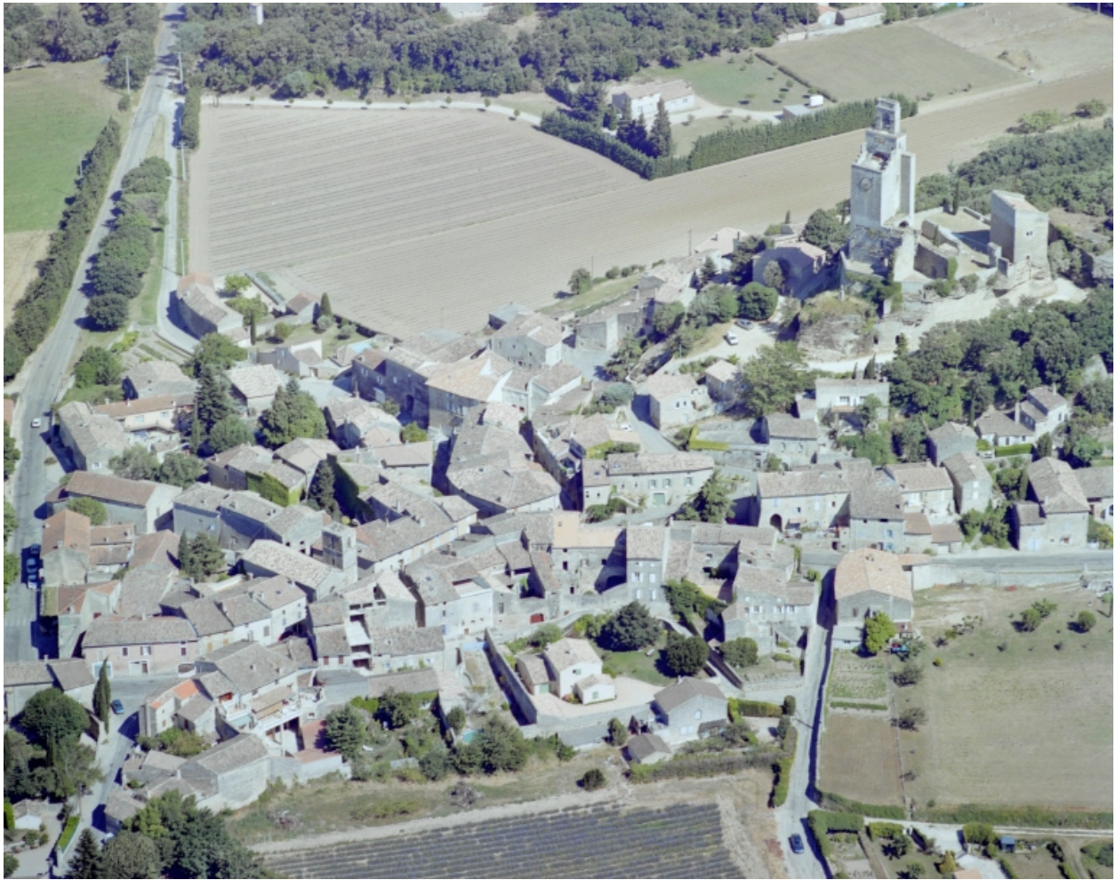
Vue aérienne de l'ensemble castral, composé des vestiges de l'enceinte et des édifices fortifiés dits la Tour de Chamaret et "le pigeonnier".
