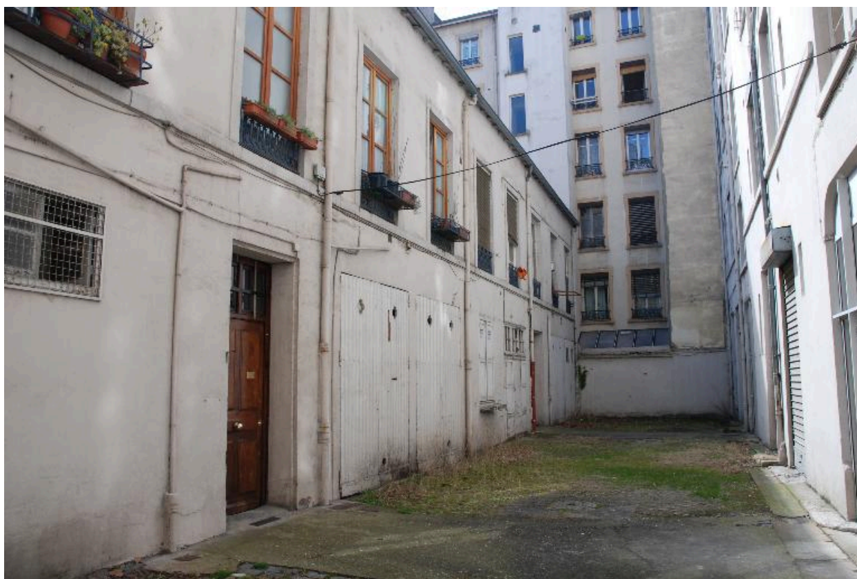
Vue du bâtiment sur cour, depuis le nord
