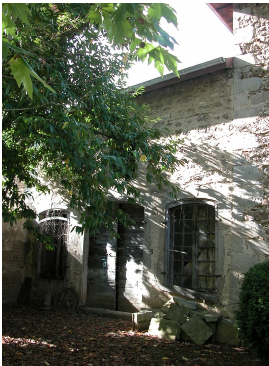
Détail de la façade sud de l'aile ouest du bâtiment ouest, datée 1761.
