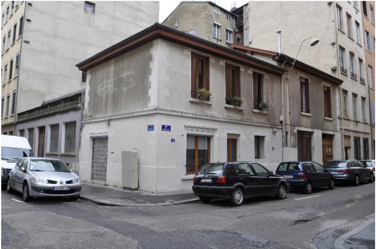
Vue d'ensemble du n°16 rue du Pavillon à l'angle de la rue Dumenge depuis l'ouest
