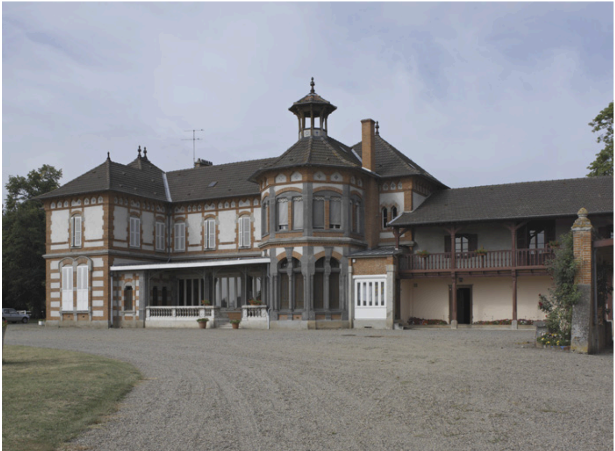
Vue d'ensemble de l'aile ouest, depuis le nord-ouest.
