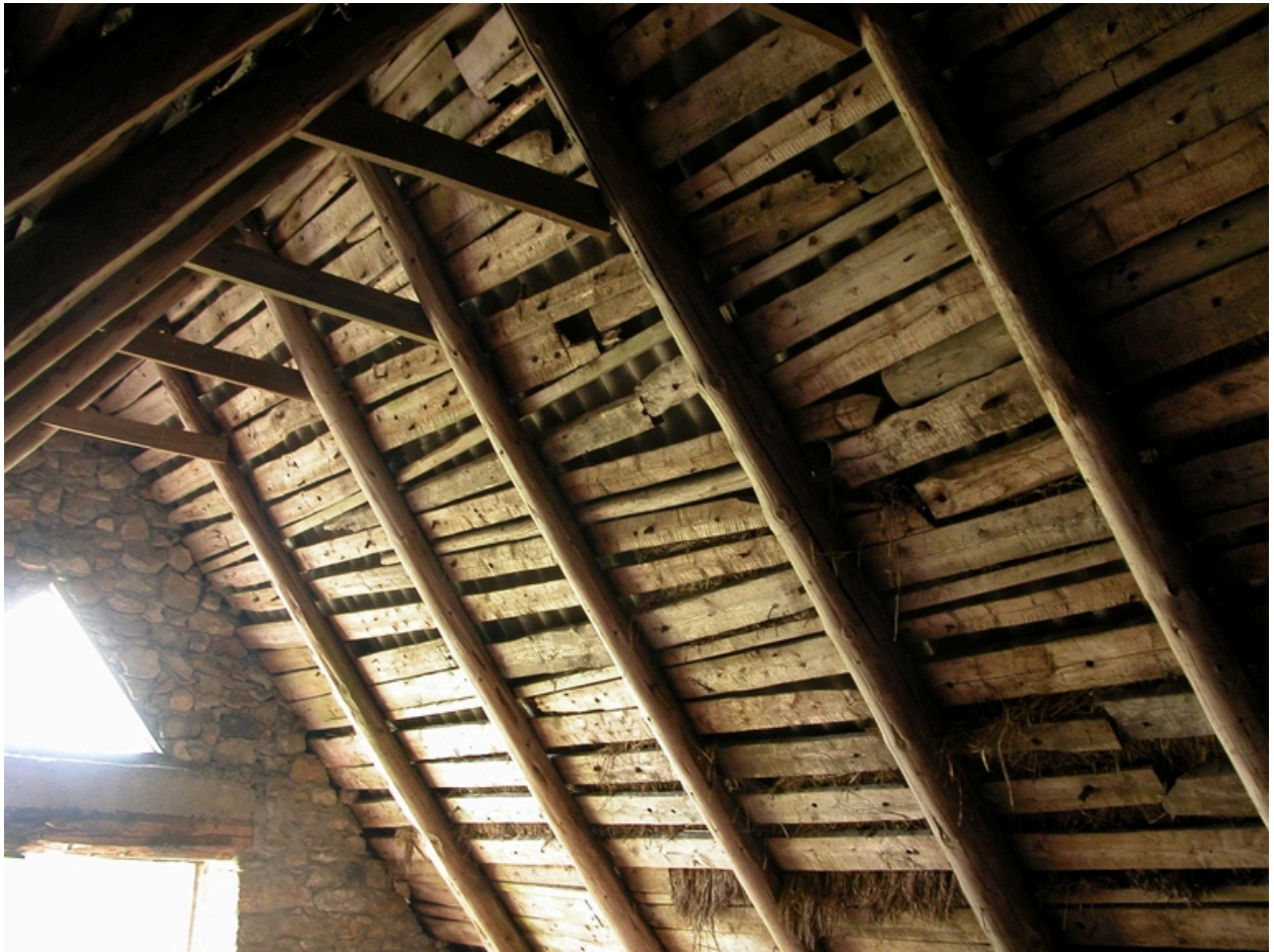
Vue intérieure de la charpente.
