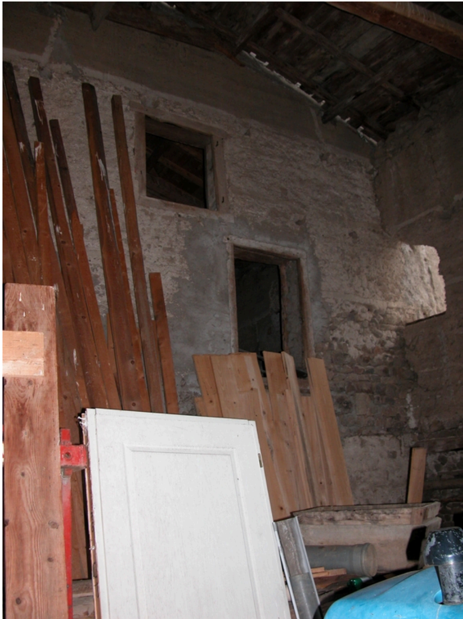
Vue intérieure de la grange-remise, depuis le nord-est : mur de séparation avec l'étable.
