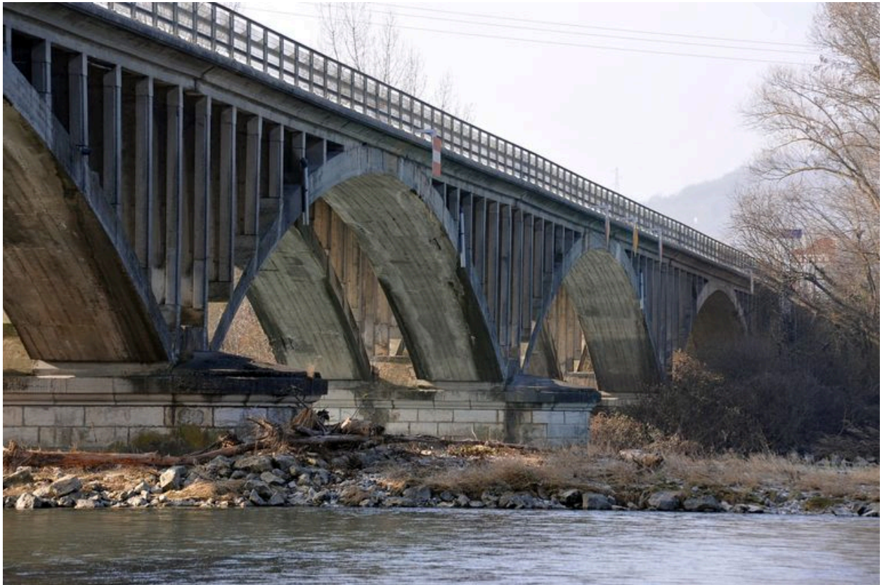
Vue partielle, de côté, face amont (depuis la rive gauche)
