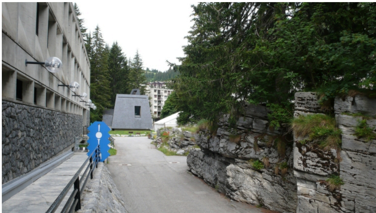
Façade nord depuis l'est
