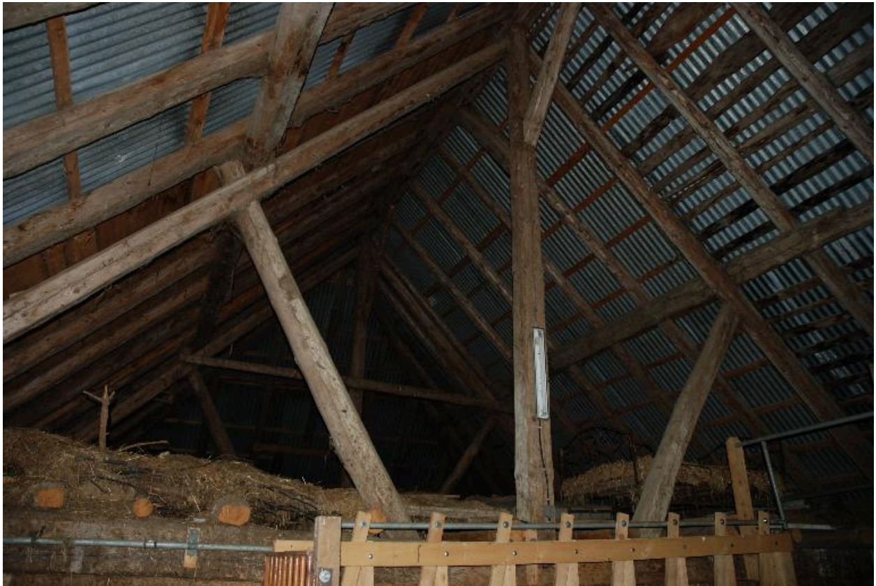
Vue intérieure de l'étable : la charpente.
