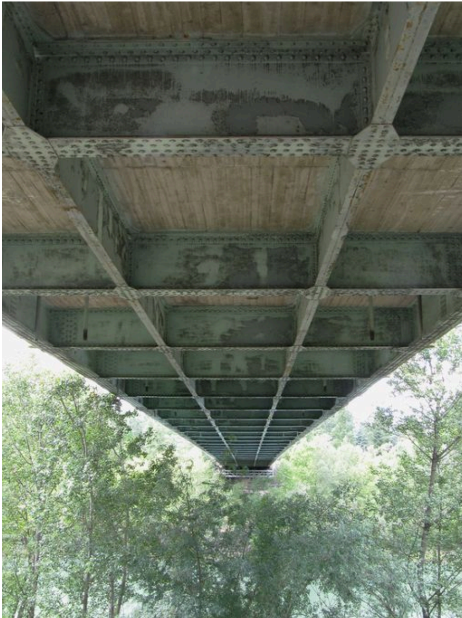
Tablier vu de dessous (depuis la rive gauche)
