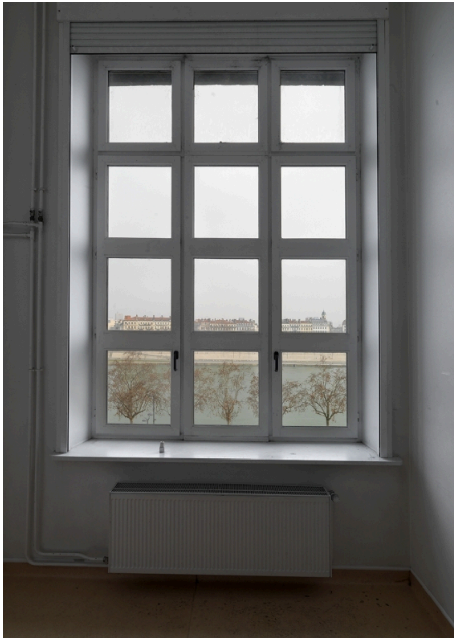
Bâtiment B. 1er étage. Une fenêtre côté Rhône
