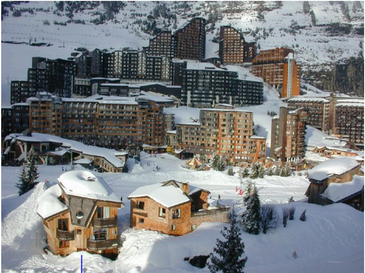
Vue d'ensemble du chalet depuis le sud
