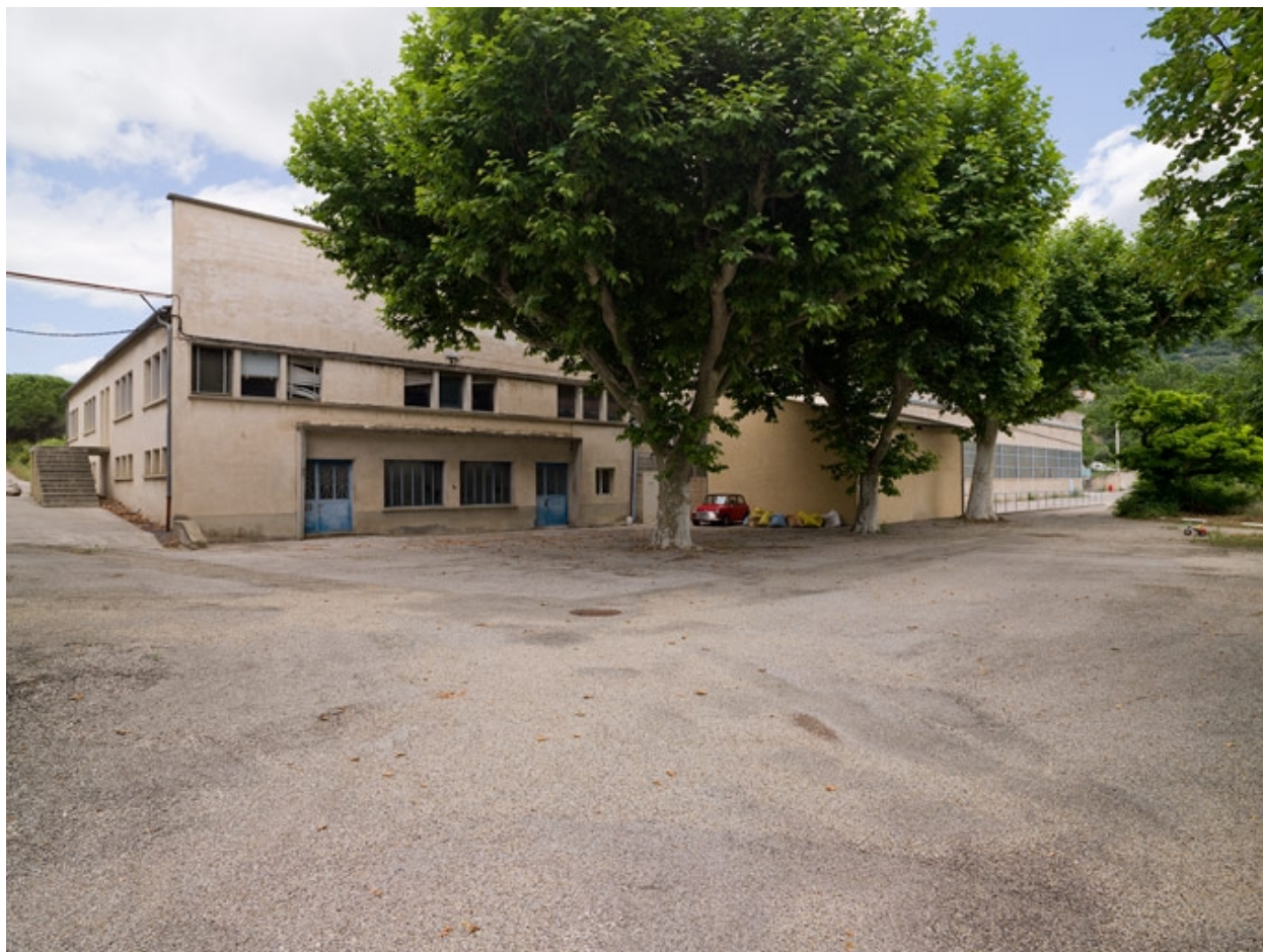
Vue d'ensemble sud-ouest
