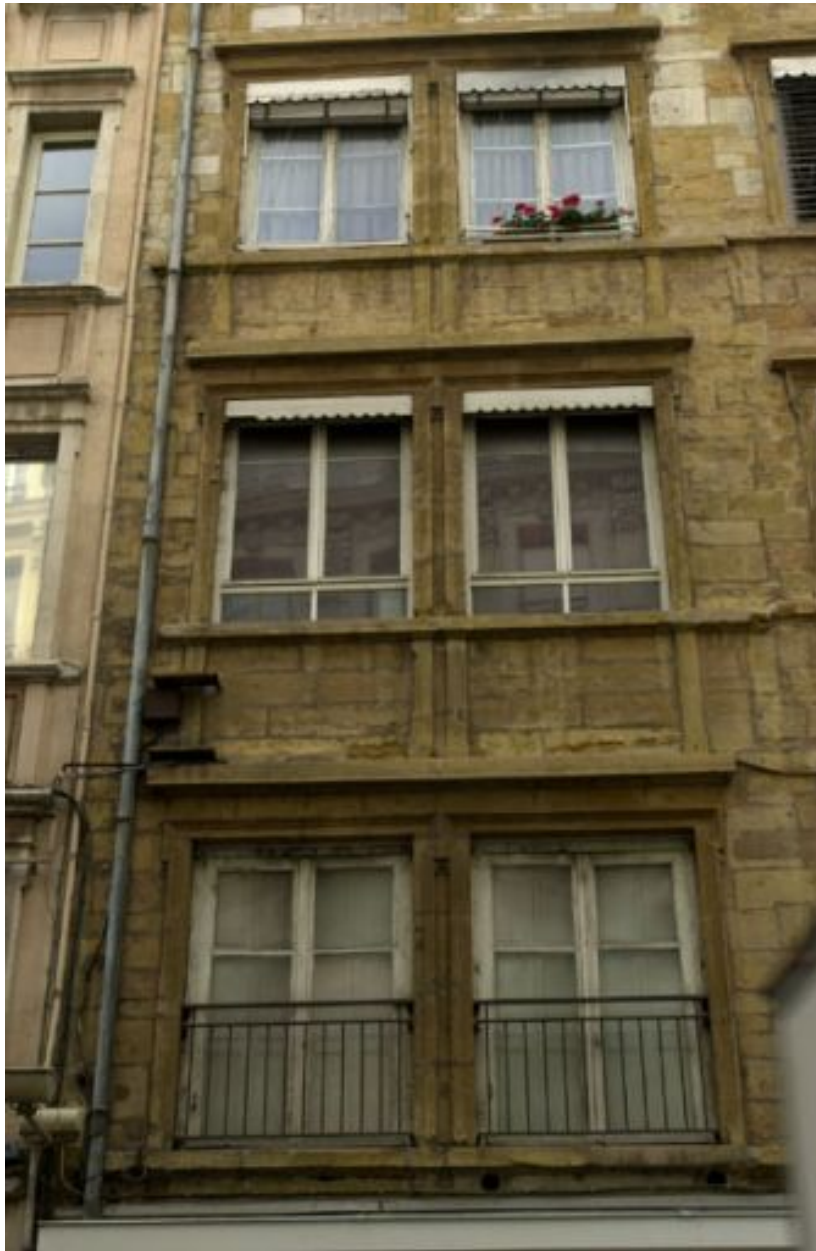
Façade rue de Brest, niveaux 2 à 4
