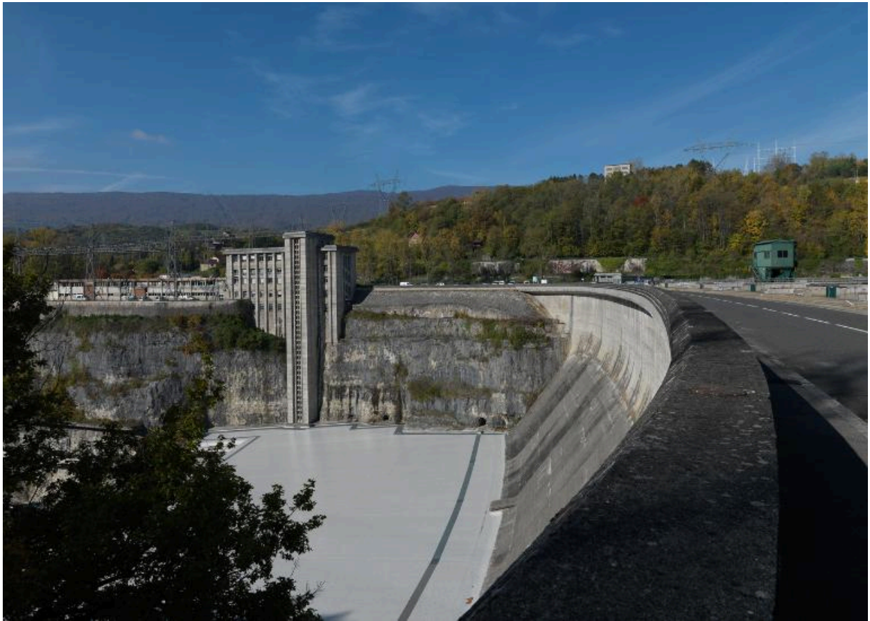
Vue d'ensemble du barrage, toit de la centrale.
