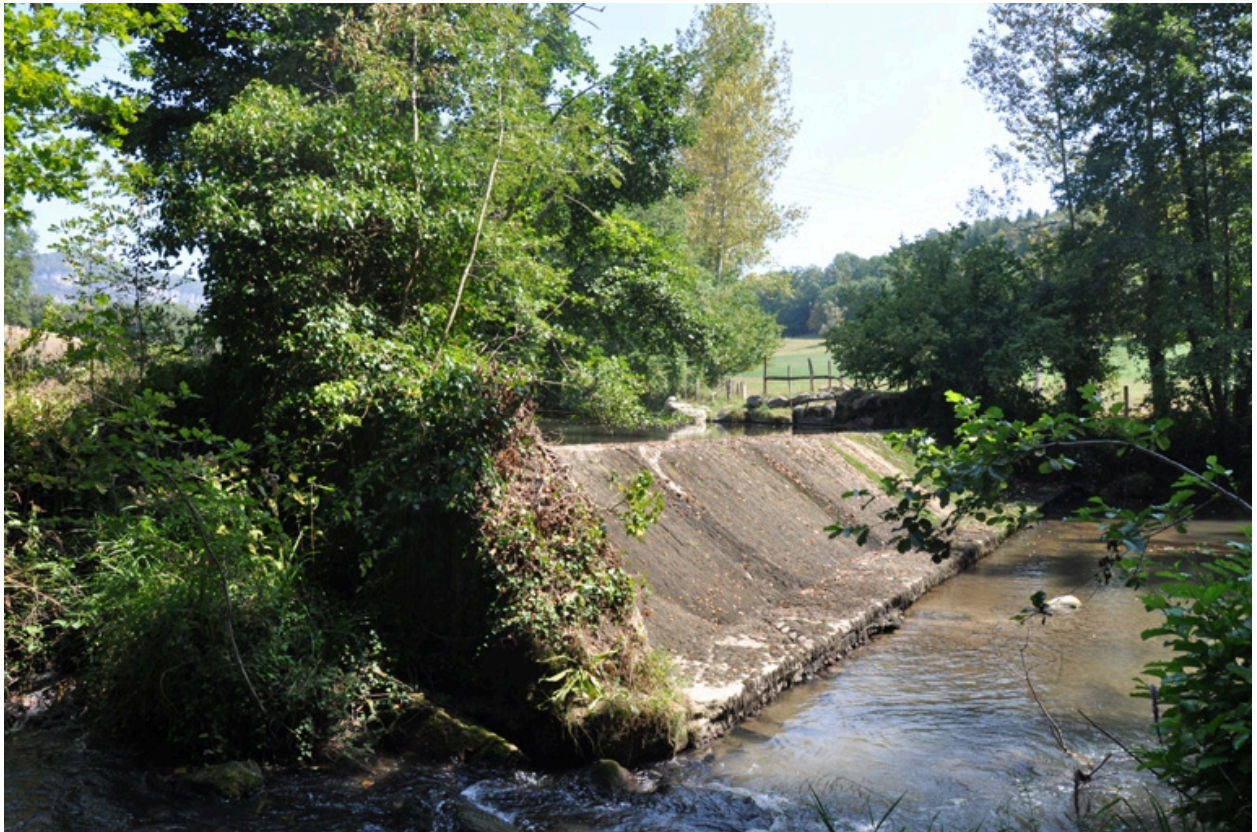
Vue du barrage sur le ruisseau du Tier
