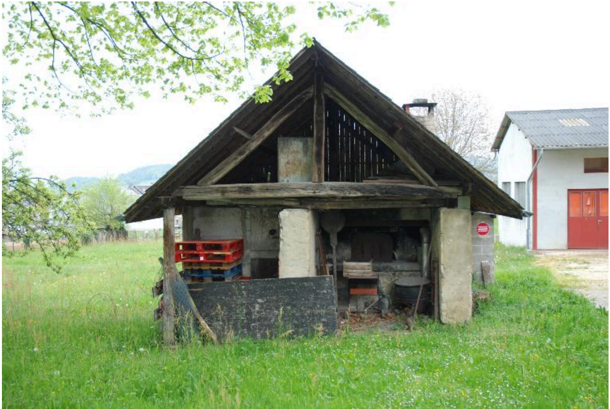
Vue du four à pain.
