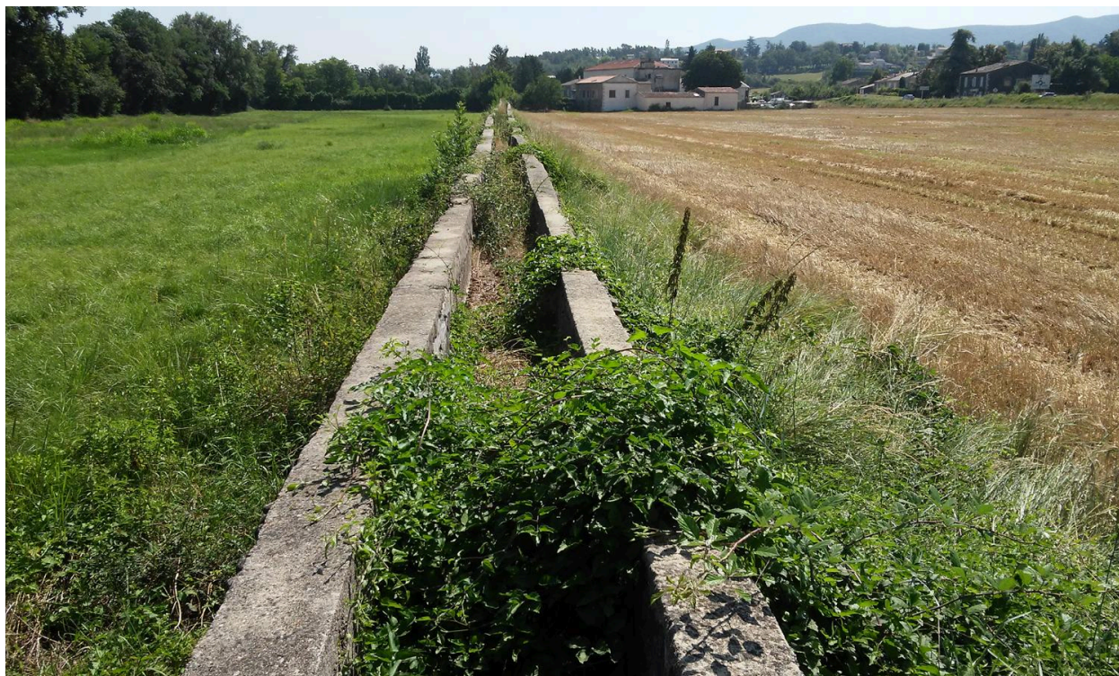
Aqueduc vue du canal par en-dessus
