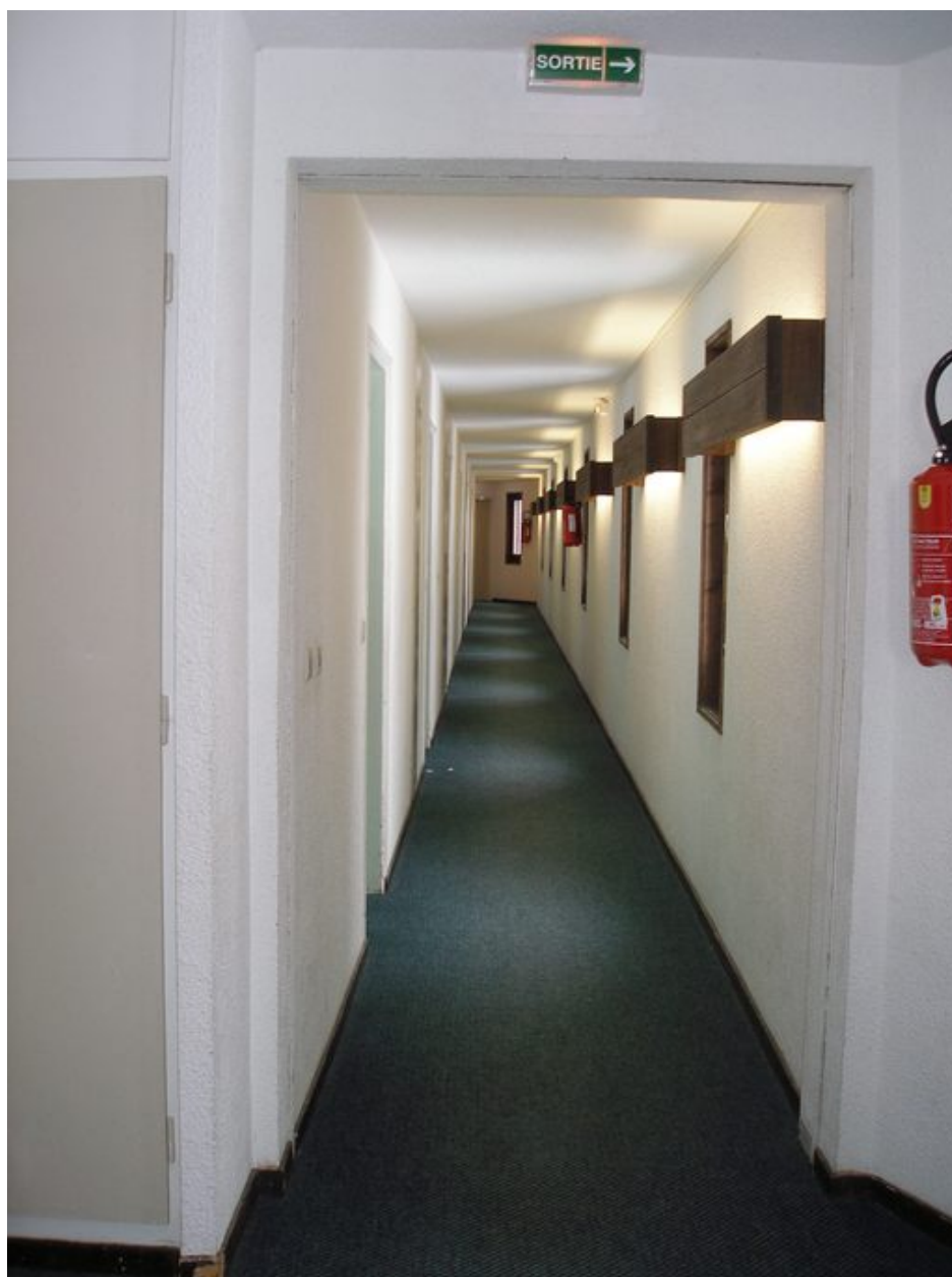
La coursive de la partie centrale
