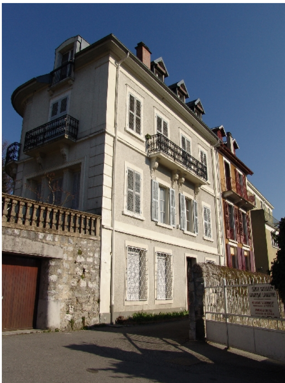
Façade orientale vue de trois-quart
