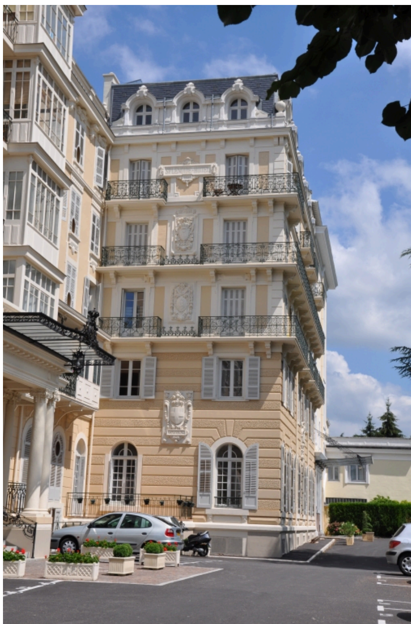
Vue de l'extension nord-est
