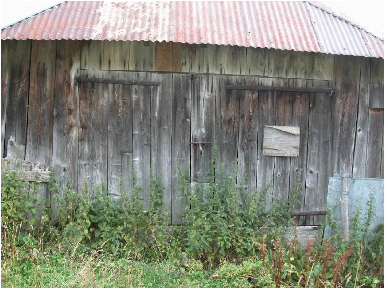
Vue de des portes aménagées dans le pignon est de l'étable.
