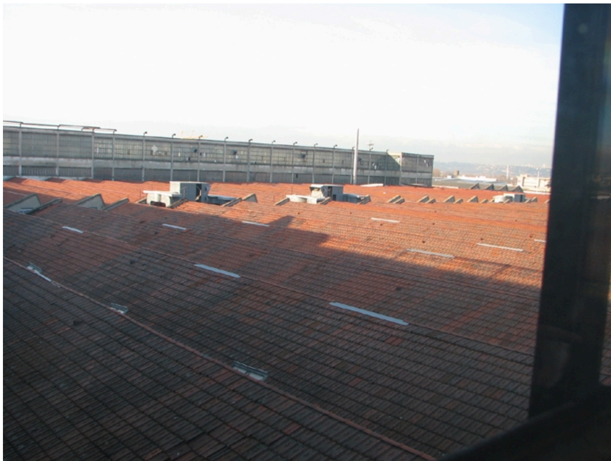
Vue d'ensemble de l'aile est et de la toiture shed des ateliers en rez-de-chaussée
