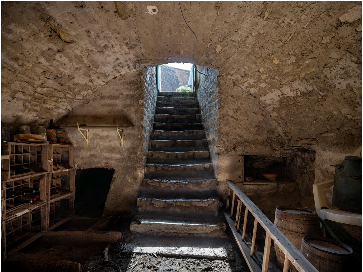
Détail de la cave et de l'escalier d'accès
