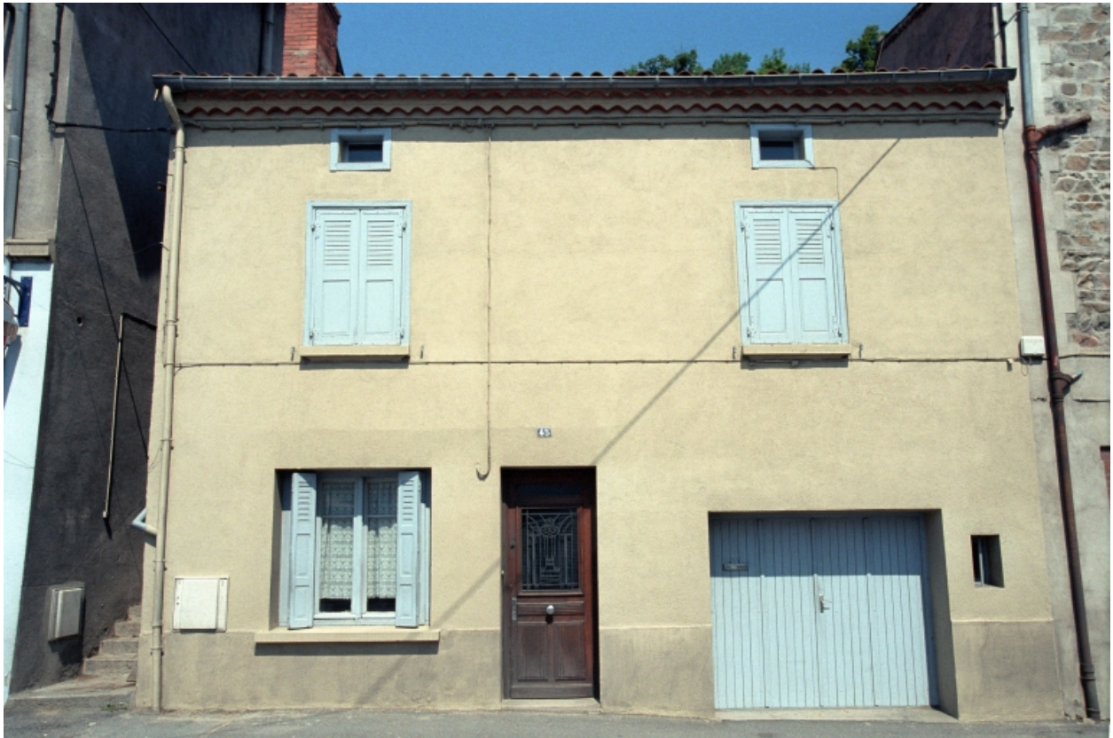
Boën, îlot 22, Lyon (rue de) 45. Vue générale de la façade sur rue.
