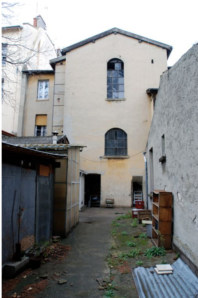
Elévation postérieure depuis le sud, détail
