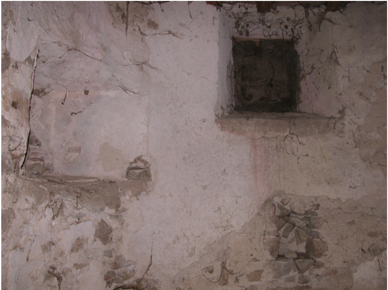
Vue intérieure de la cave voûtée à l'étage de soubassement.
