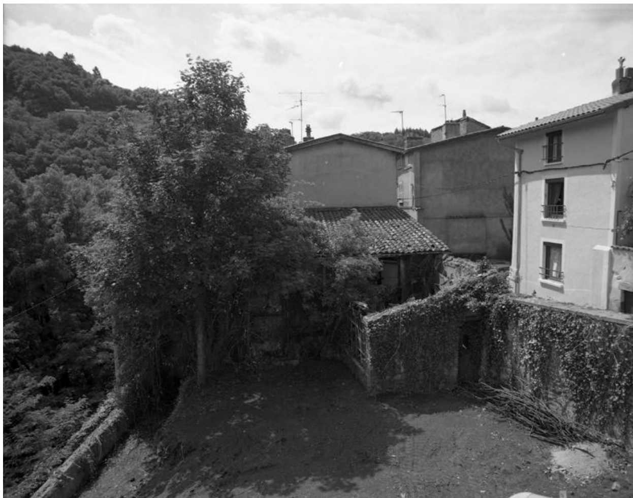
Ateliers au fond du jardin de la maison, côté sud, avant les travaux de reconstruction et d'agrandissement.
