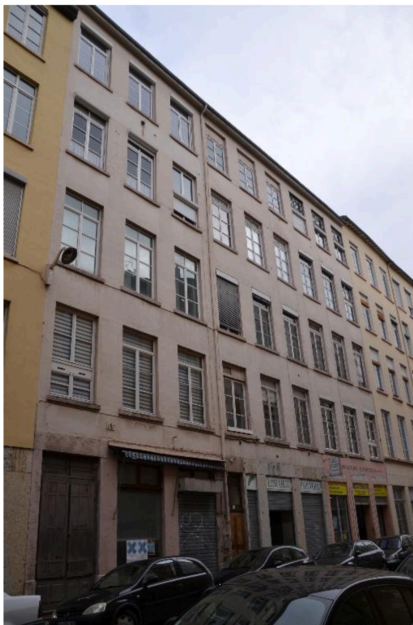
Vue d'ensemble façade sud
