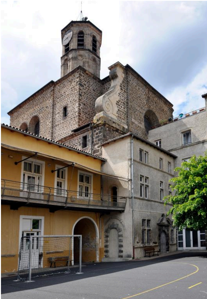
Cour 2, angle nord-ouest, depuis le sud : pavillon faisant jonction entre les bâtiments C et E
