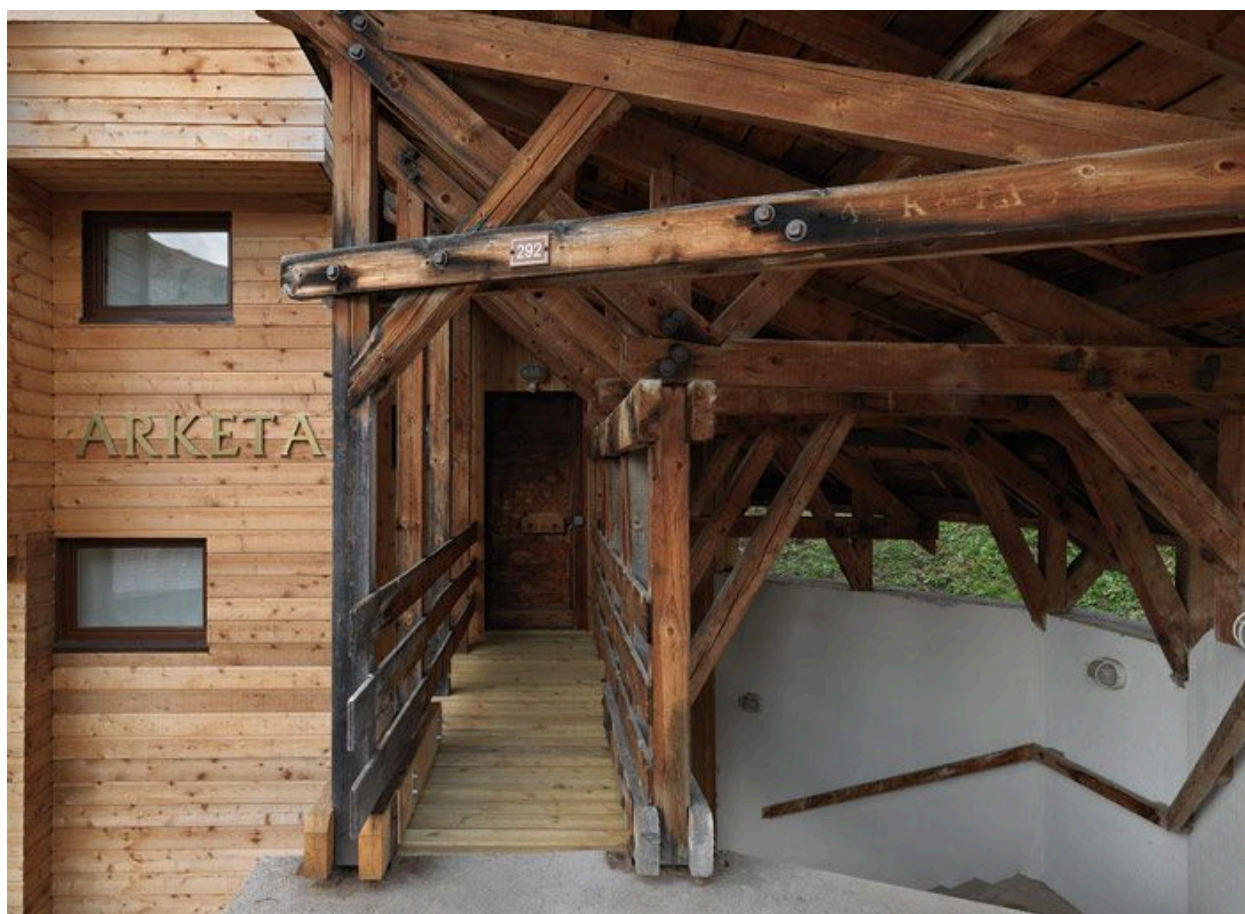
La galerie d'entrée
