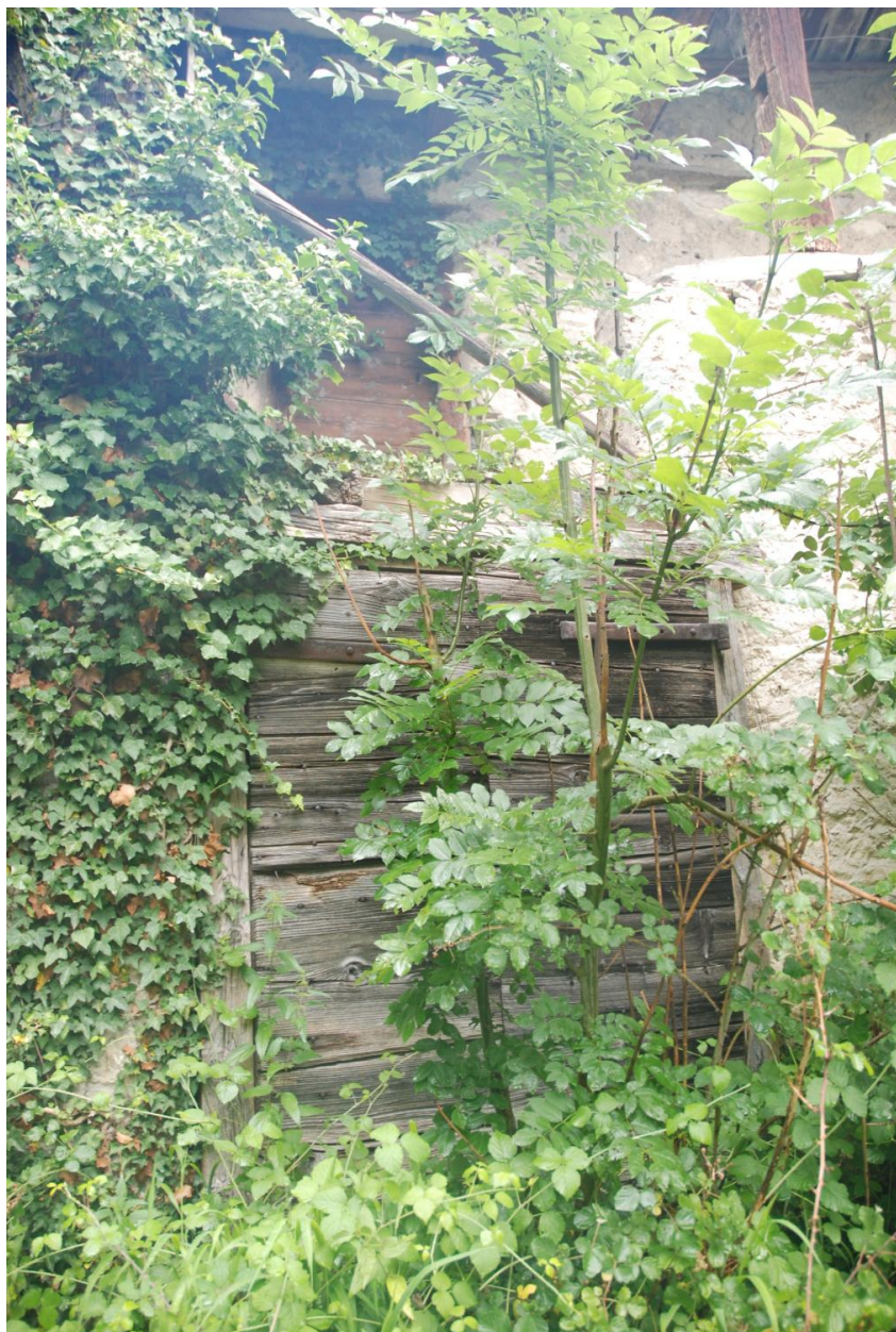
Jonction avec le cellier voisin (2018 E3 1010).
