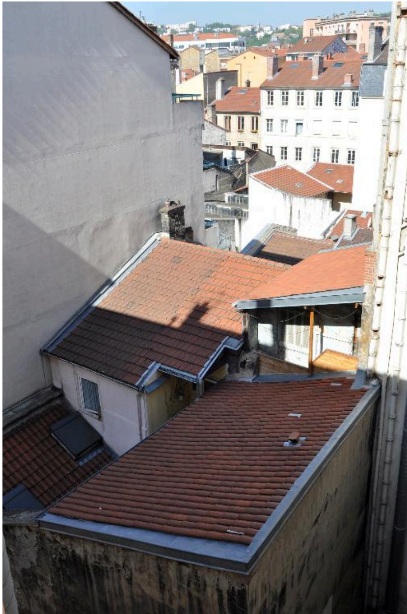
Vue de toiture, bâtiments sur cour
