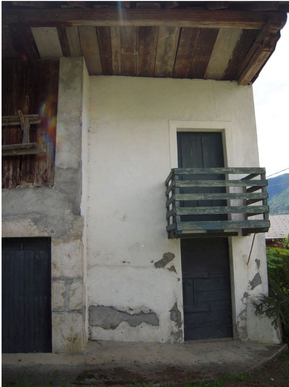
Vue de la partie rajoutée à l'ouest.
