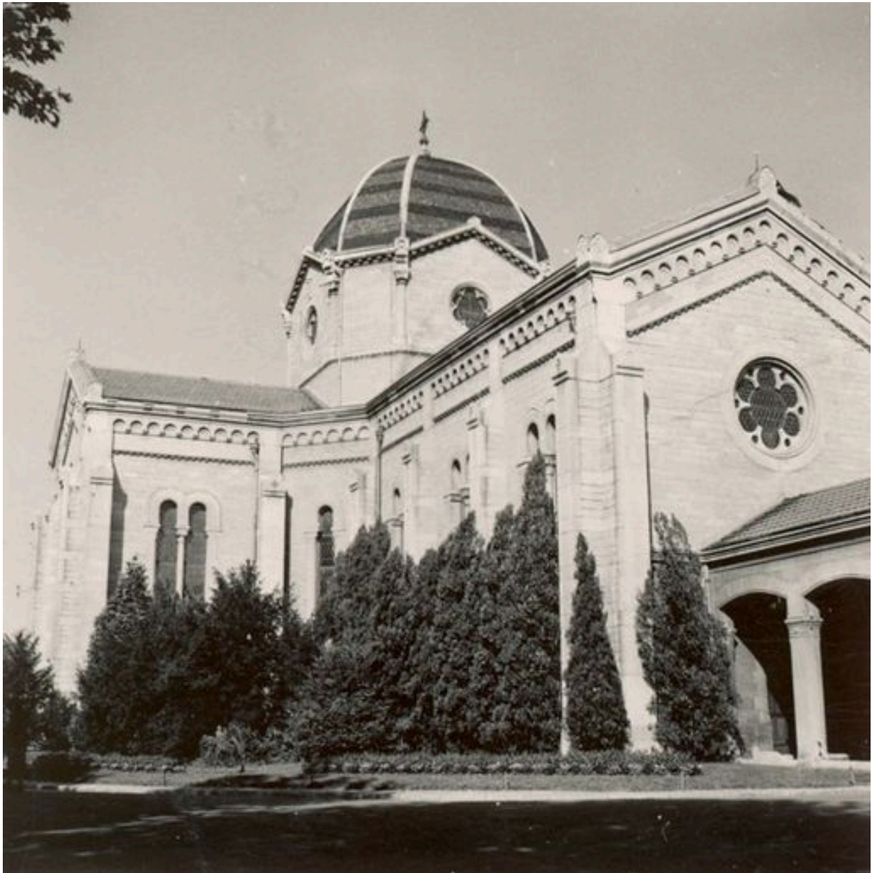
La chapelle vue du sud-ouest, avant démolition des portiques en 1956
