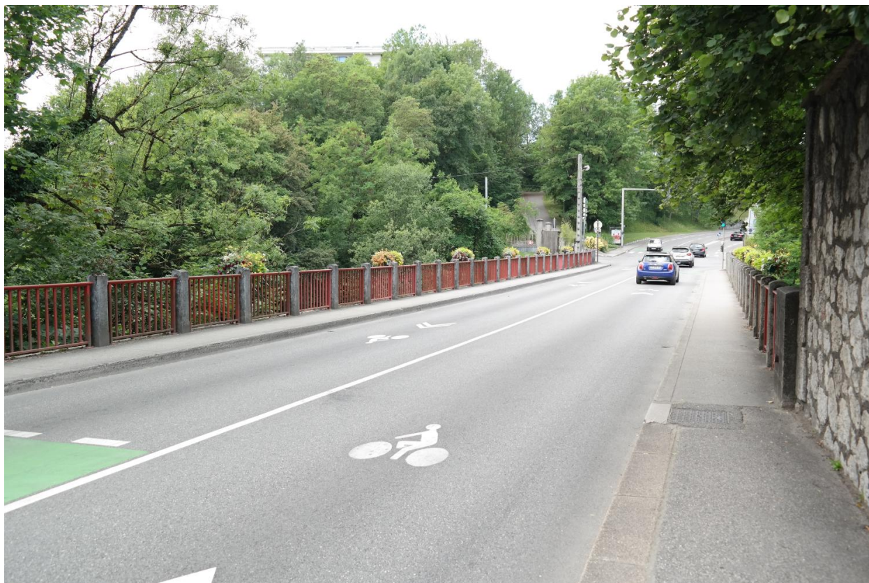
Pont de Tasset, vue de la chaussée
