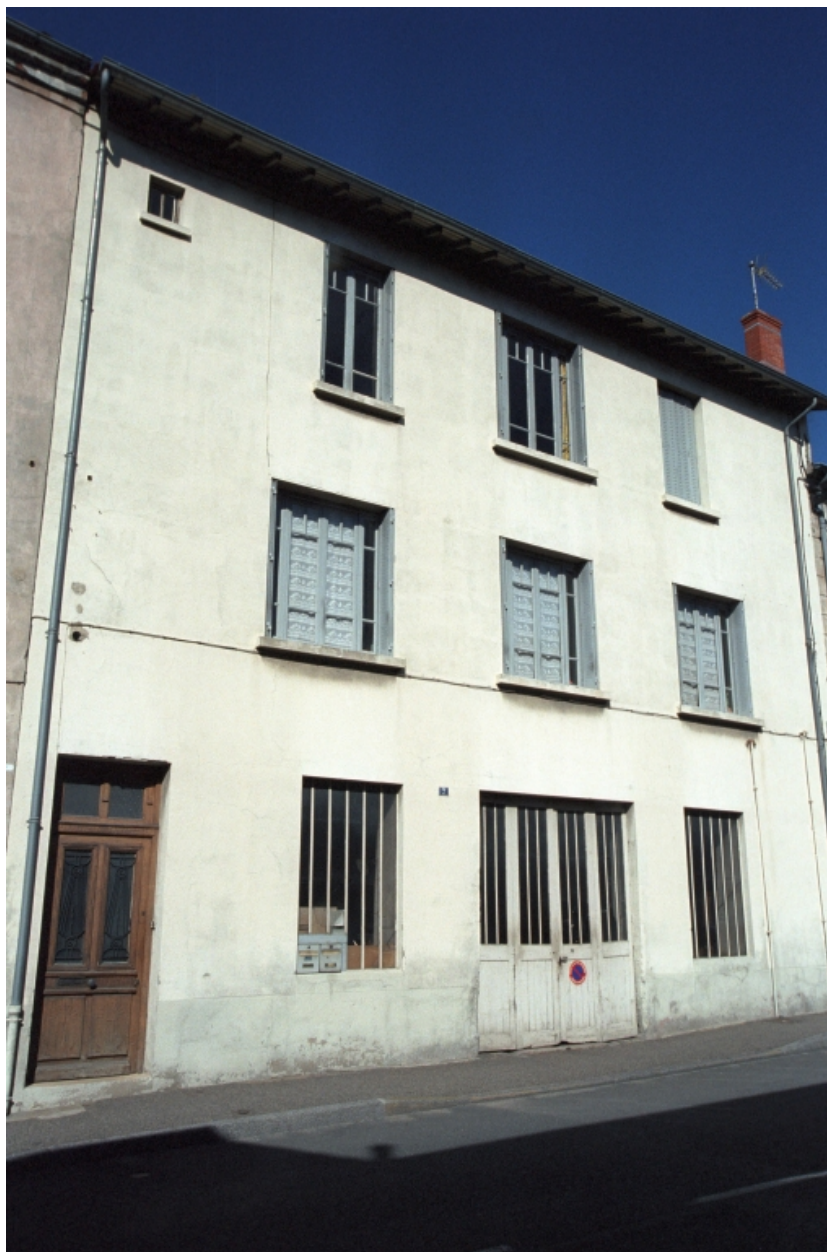
Boën, îlot 11, Clermont (rue de) 7. Vue générale de la façade sur rue.
