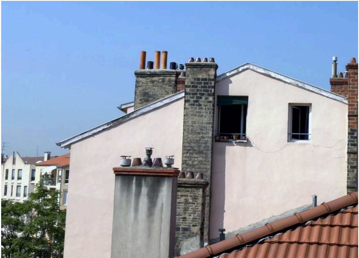
Détail du comble : ouvertures dans le mur pignon
