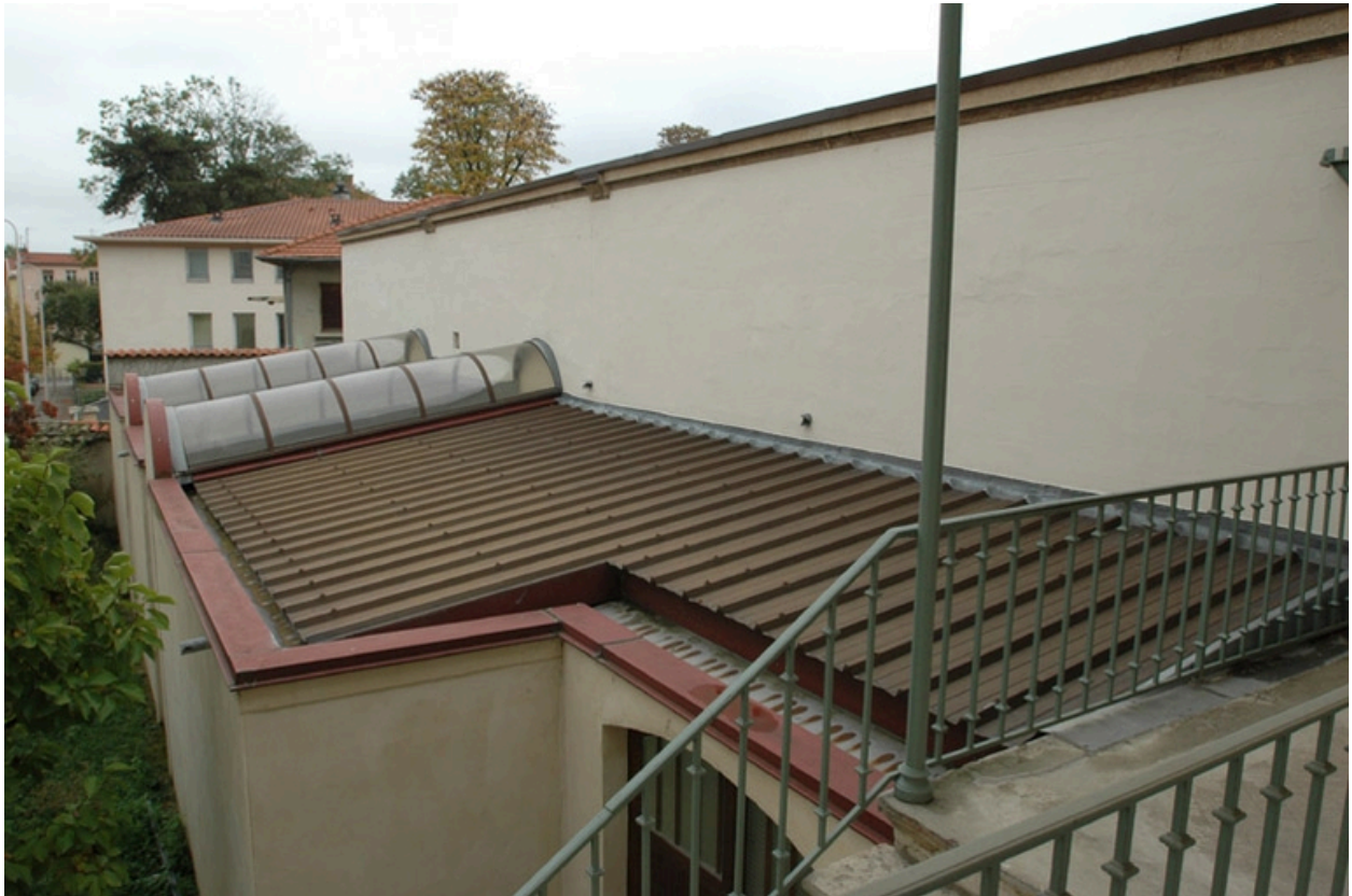
Extension nord détail lanterneau
