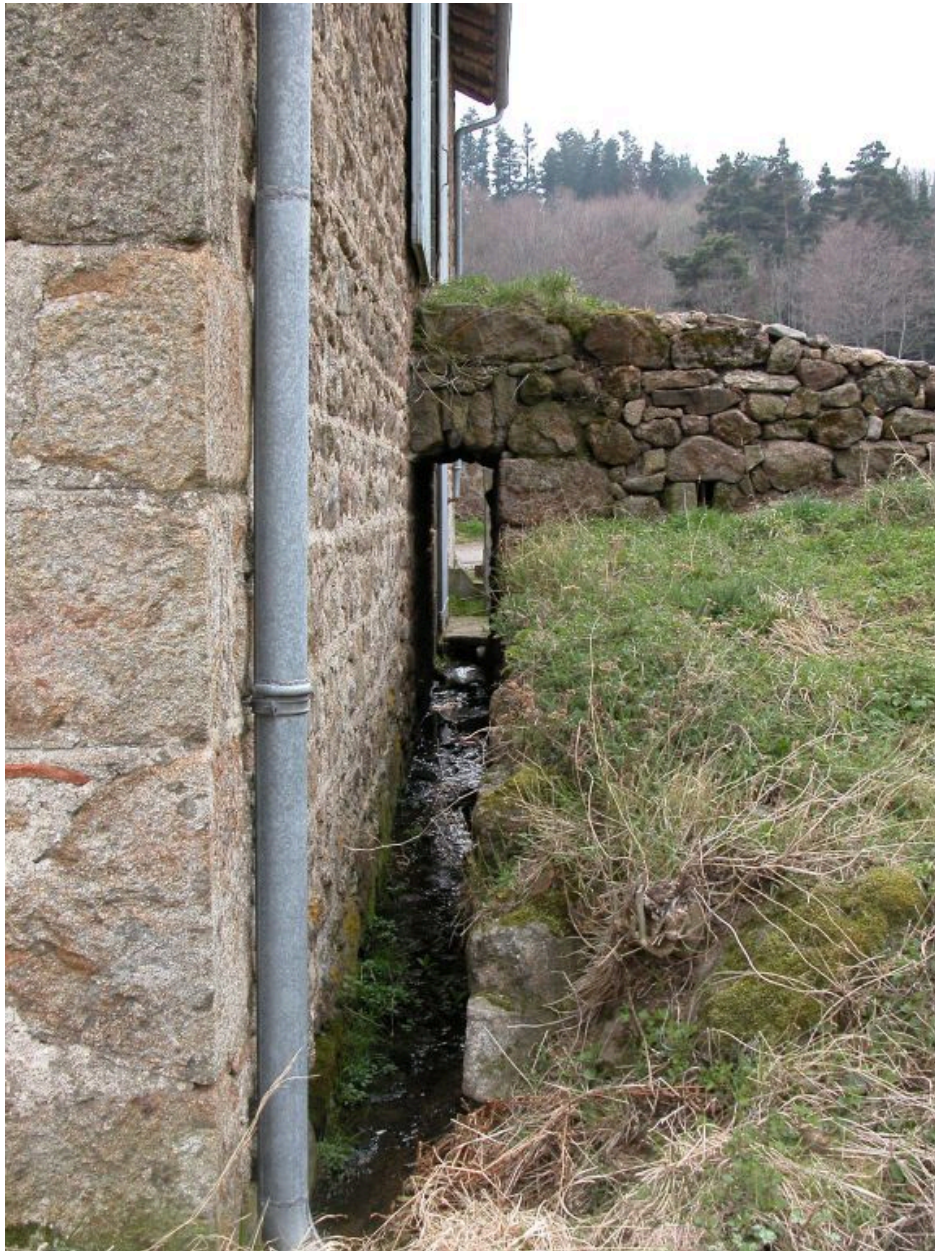
Vue arrière de la ferme avec une rigole basse pour la circulation de l'eau.
